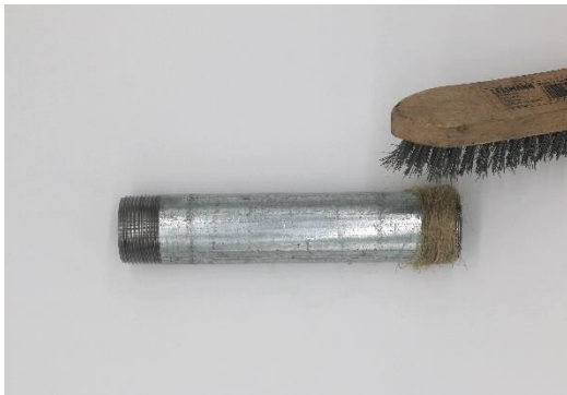
Bild 3 Einarbeiten des Hanfs in die Gewindegänge mit einer Stahlbürste
