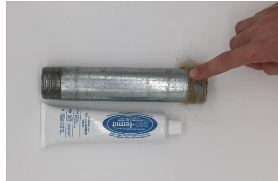
Bild 4 Befeuchten mit der Fermit Paste
